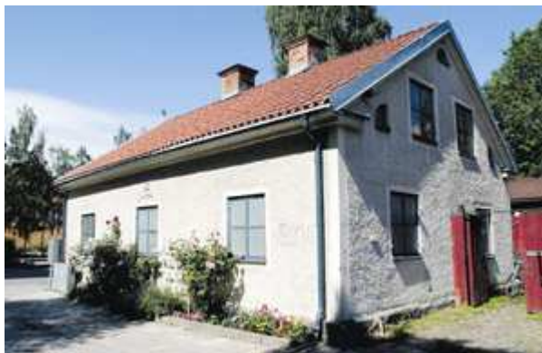
Det kraftiga vattenflödet i Torshagsån, riskerar att
